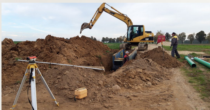
Prace w miejscowości Mortęgi
