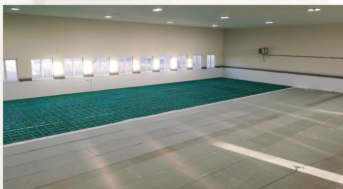
W ostatnich dniach trwały prace przy układaniu podłogi pod planowane boisko do rozgrywek w futsalu, piłce ręcznej i siatkówce
