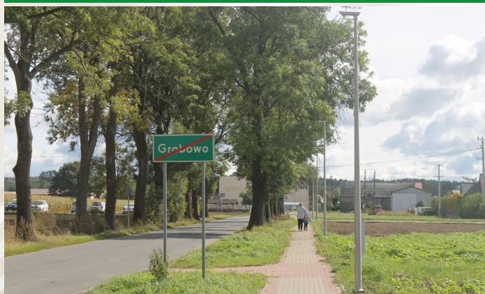
Wykonanie oświetlenia parkowego pomiędzy Wałdykami a Grabowem. W ramach zadania zamontowane zostały 23 lampy parkowe przy chodniku łączącym miejscowości. Dzięki zwiększonej widoczności, przestrzeń jest bezpieczniejsza dla przechodniów i innych użytkowników ruchu drogowego.
