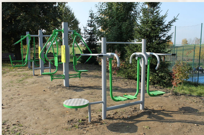
Budowa ogólnodostępnych siłowni zewnętrznych dla mieszkańców gminy Lubawa na terenach przyszkolnych w Prątnicy, Rożentalu oraz Samplawie. Na obiektach zamontowano urządzenia do ćwiczeń, stoły do gry w piłkarzyki, warcaby, szachy oraz ławki i stojaki na rowery.
